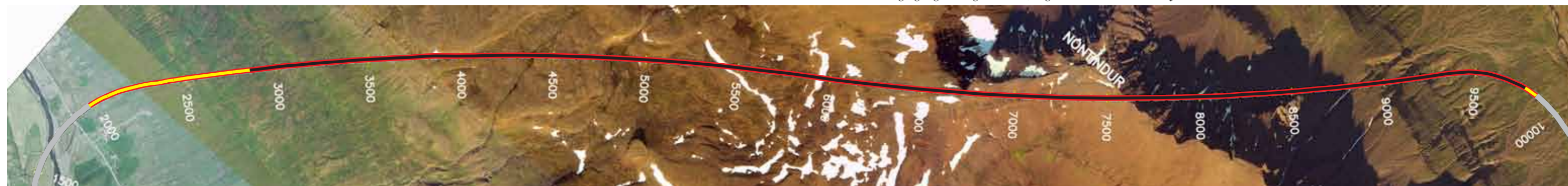
Norðfjarðargöng, staða framkvæmda 17. mars 2014. Búið er að sprengja 940 m sem er 12,5% af heildarlengd.
